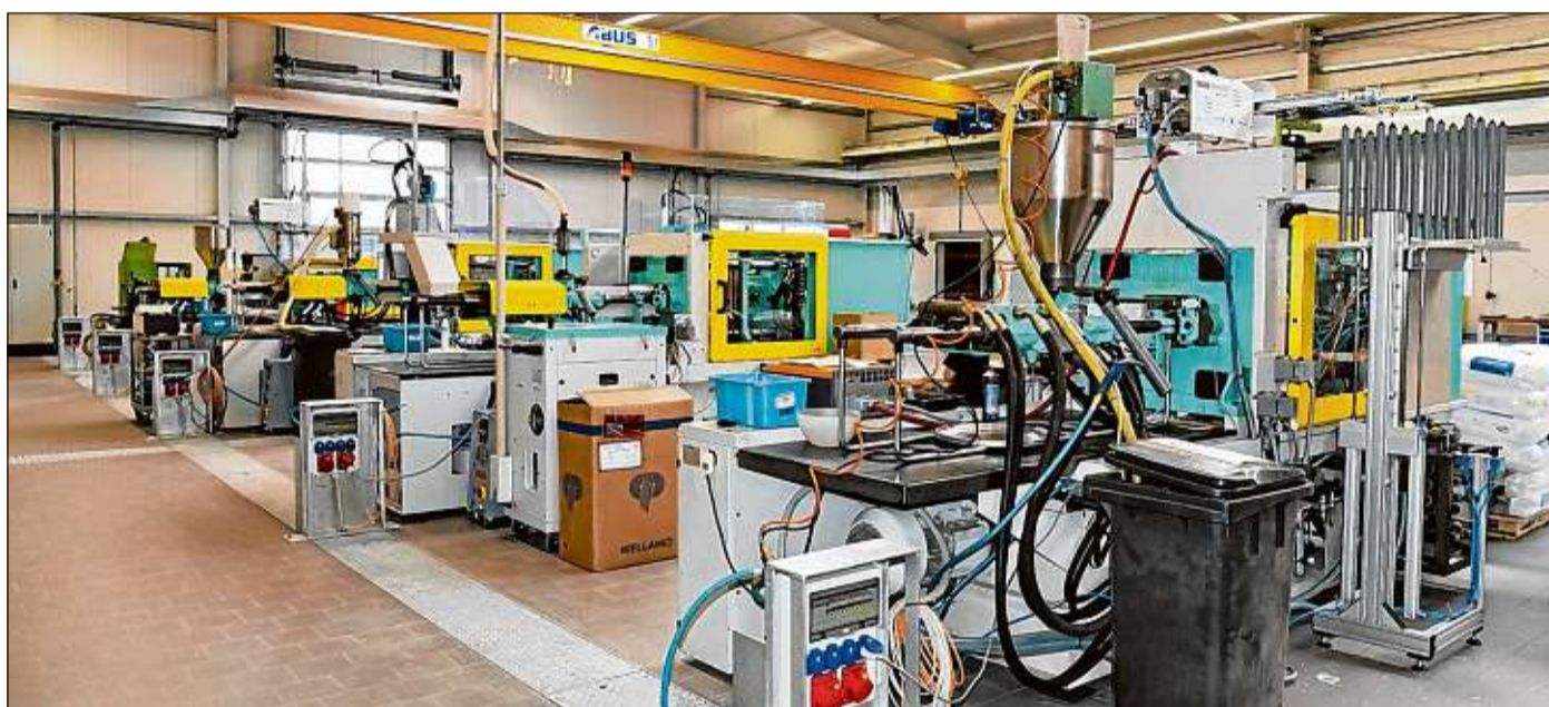
Die neue Cuba Werkhalle ist groß. Während einige Maschinen bereits laufen, werden andere noch geliefert und aufgebaut. An jedem Arbeitsplatz werden für die Mitarbeiter Tische für den Versand aufgestellt.
